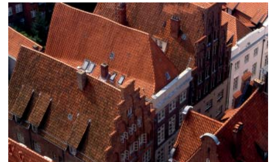
Foto: Hohlpfannendächer in Lübeck © H.Zanger
